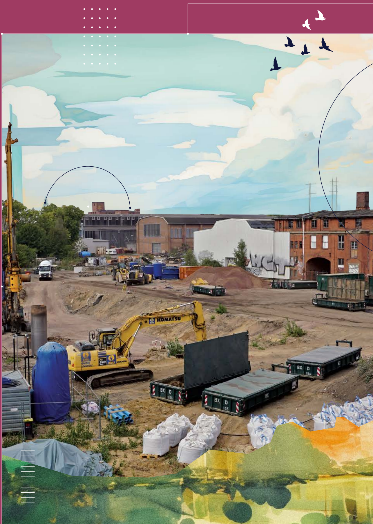
Baustellenansicht Großlochbohrungen, ehem. MAW Liebknechtstraße Magdeburg. | © LAF
