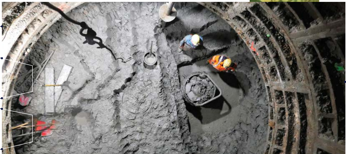
Rückbau der Tonabdichtung des alten Pfropfens in 370 m Teufe. | © Plejades
