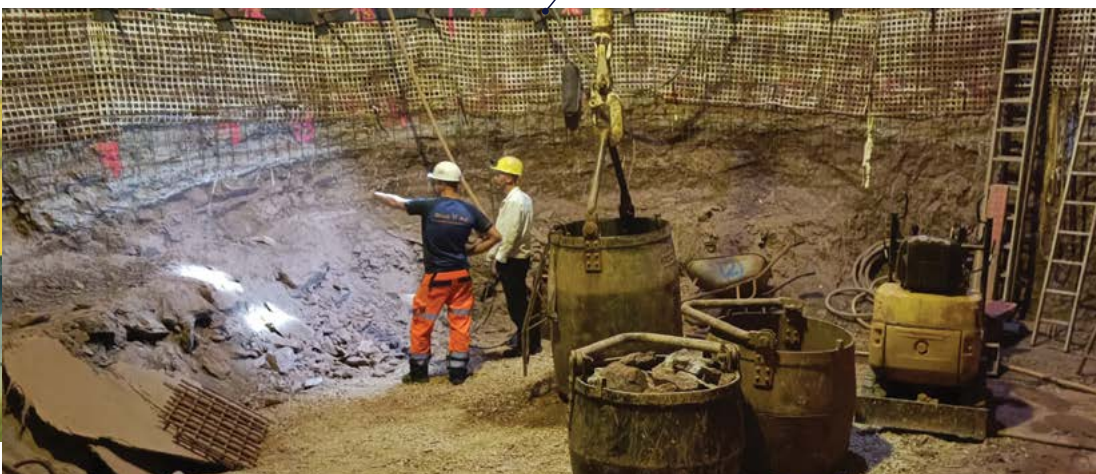
Arbeiten zur Sicherung der Bruchlocke in ca. 715 m Teufe im Jahr 2023. | © Plejades
